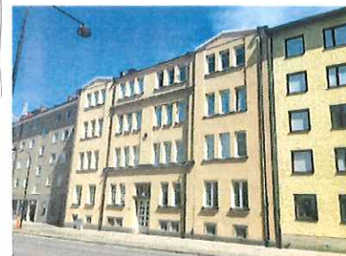
Fastigheten på Djurgårdsgatan 13 uppfördes 1907 efter Janne Lundins ritningar. Delar av utsmykningen hyvlades av vid en renovering 1958.
